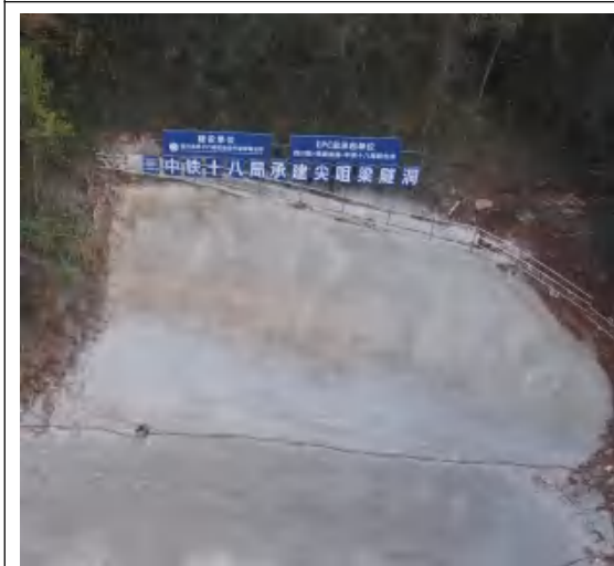
尖咀梁隧洞入口截排水沟
