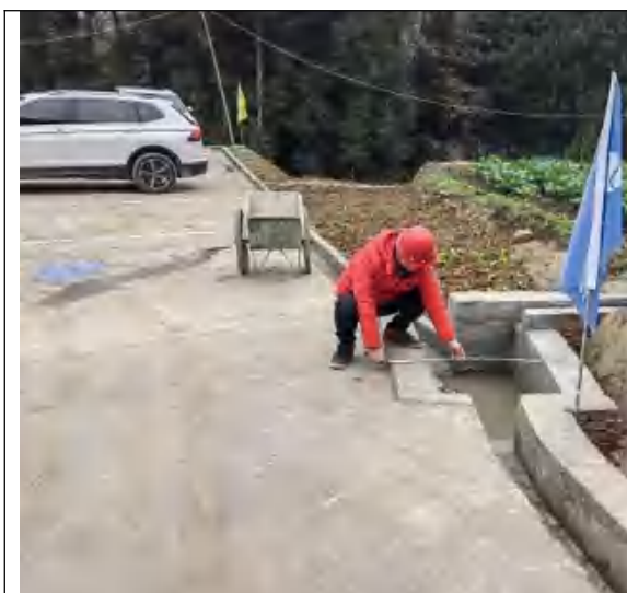
大奎山隧洞出口施工生产生活区
