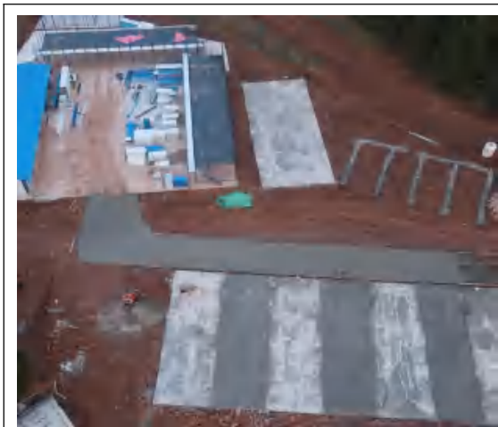
西阳山隧洞入口施工生产生活区
