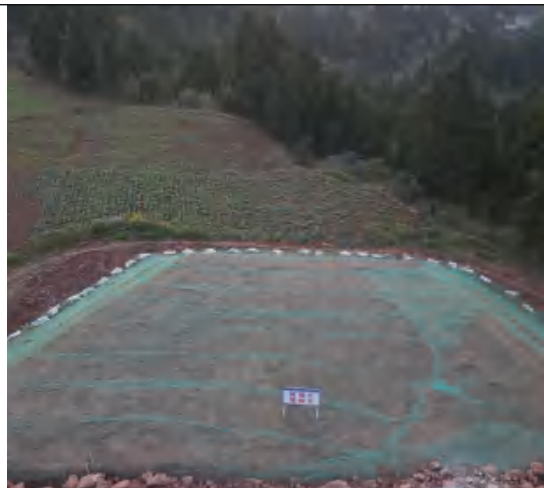
西阳山隧洞入口表土堆放及防护
