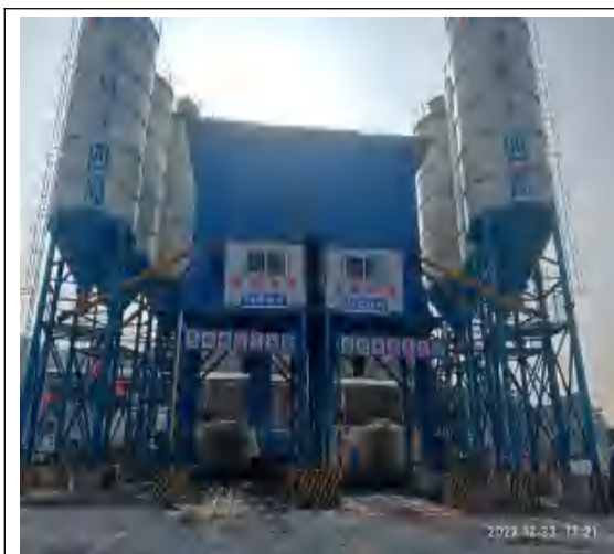
桐子坝施工生产生活区
