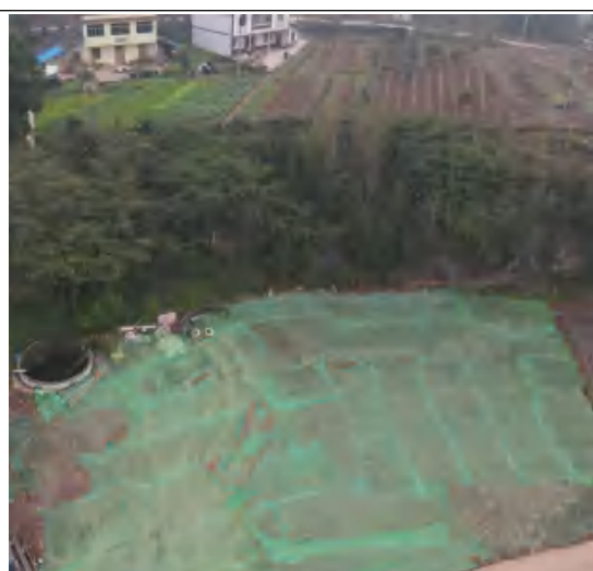
高家湾隧洞入口临时遮盖
