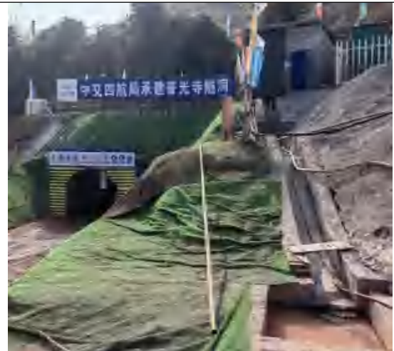
普光寺隧洞入口临时遮盖、截排水沟
