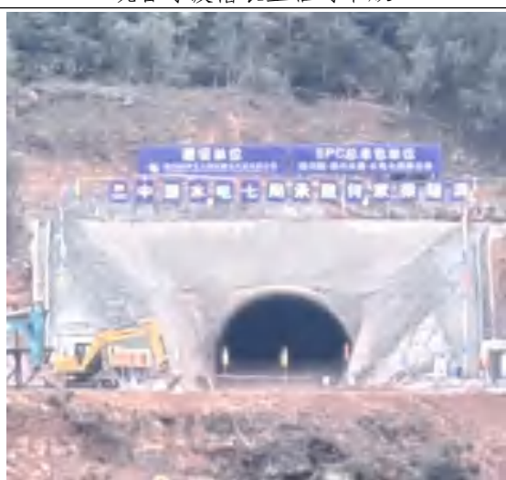
何家梁隧洞入口截排水沟
