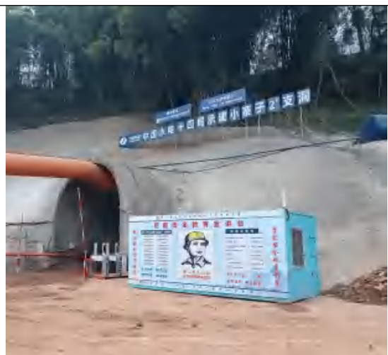
小寨子 2#支洞截排水沟
