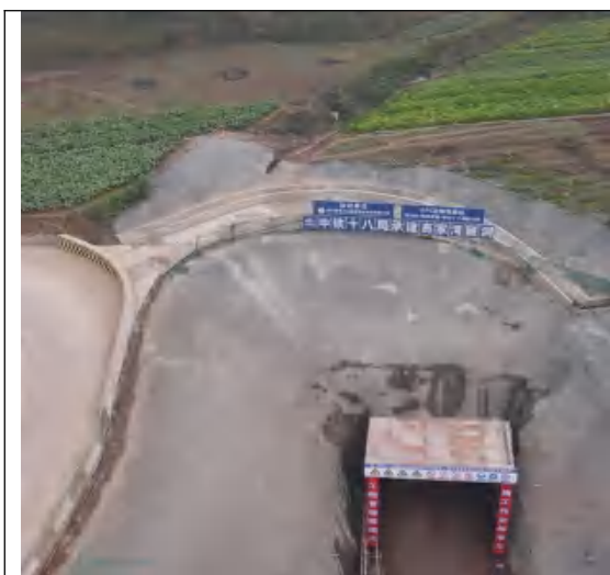
高家湾隧洞入口截排水沟
