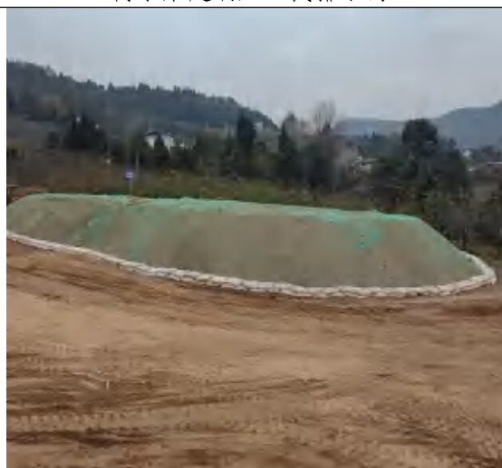
李家咀隧洞出口表土临时堆放
