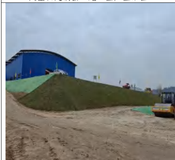
观音寺渡槽施工生产生活区
