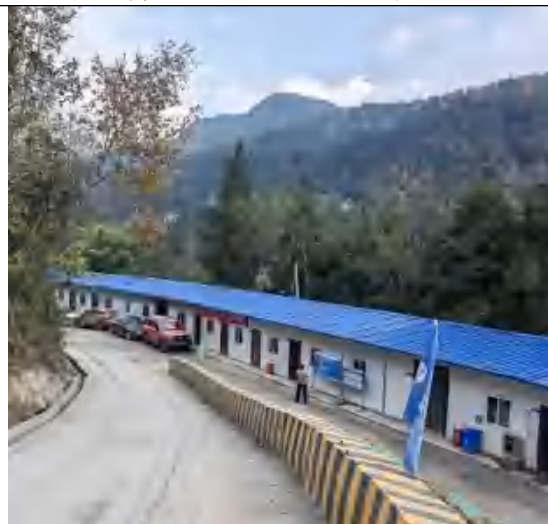
长岗岭隧洞出口施工生活区
