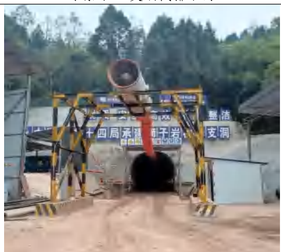
狮子岩隧洞检修支洞
