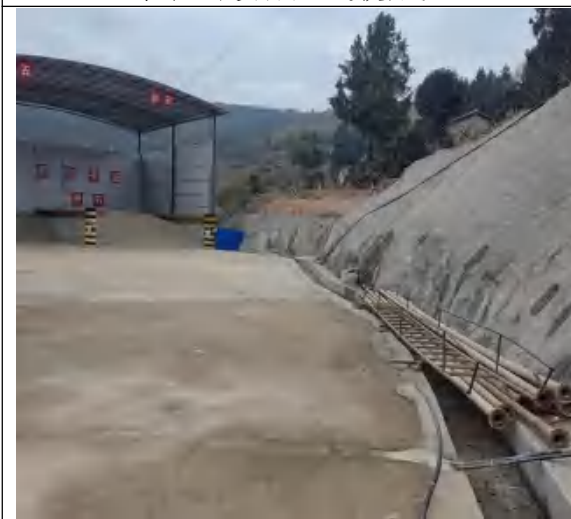
李家咀隧洞出口施工生产生活区
