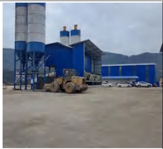
李家咀隧洞出口施工生产生活区
