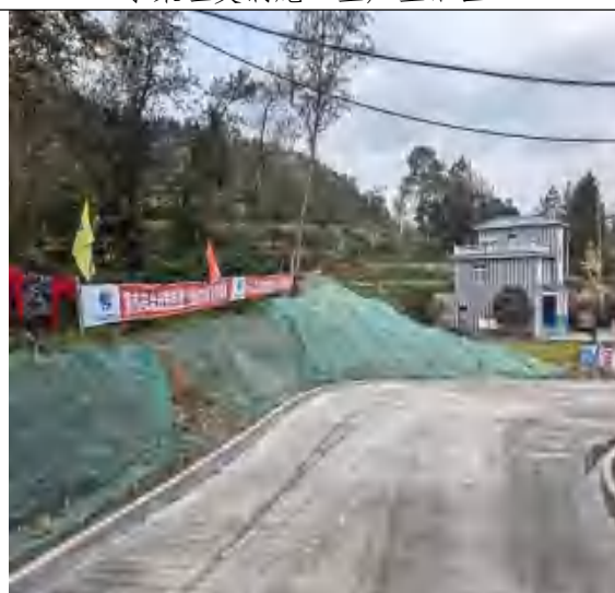
长岗岭隧洞出口边坡临时防护
