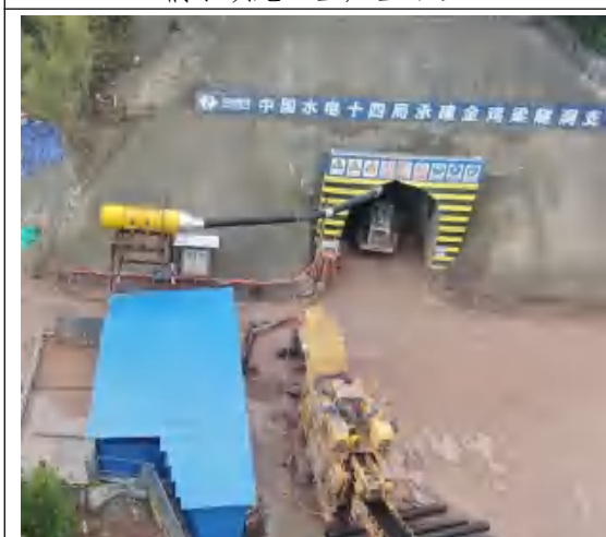
金鸡梁支洞截排水沟
