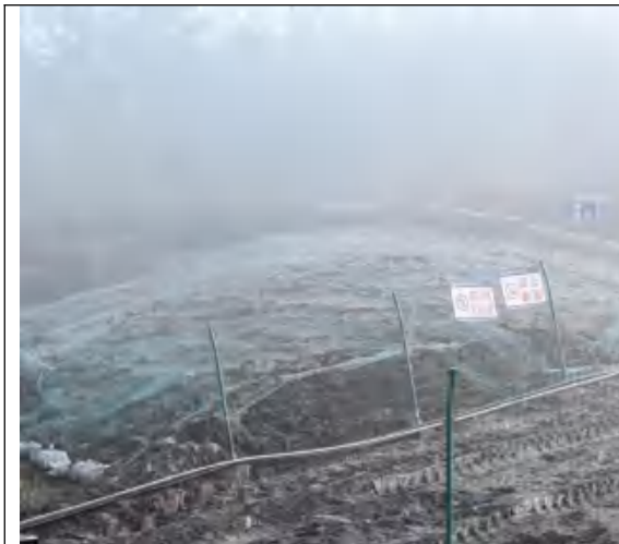
五通庙隧洞出口表土临时堆放
