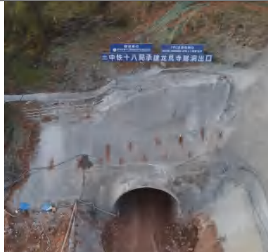
龙凤寺隧洞出口截排水沟
