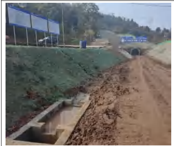
龙王寨支洞边坡临时遮盖、沉砂池
