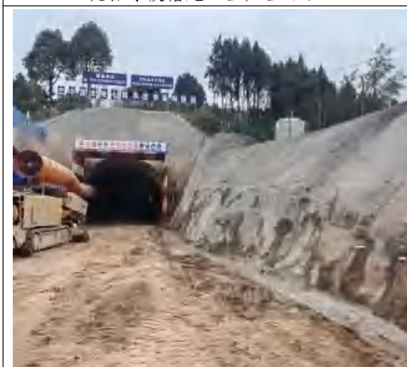
李家咀隧洞出口截排水沟
