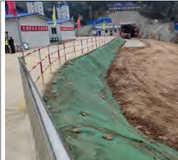
李家咀隧洞出口边坡防护
