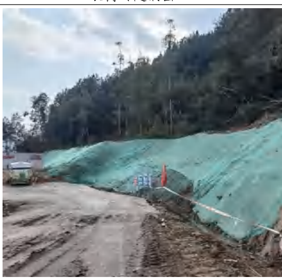
长岗岭隧洞出口边坡临时防护
