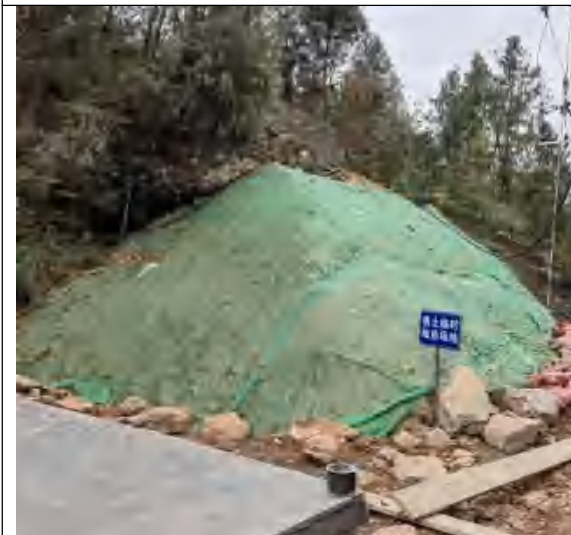
李家咀支洞表土堆放及防护
