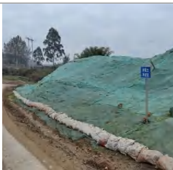
观音寺渡槽表土临时堆放
