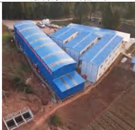
龙凤寺隧洞出口施工生产生活区
