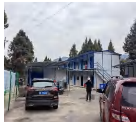
小梁咀支洞施工生产生活区
