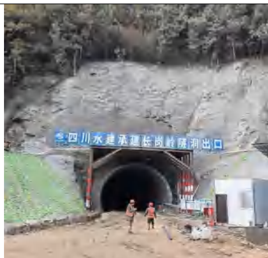
长岗岭隧洞出口
